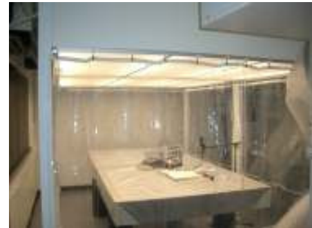
Folienvorhang mit Rollen und Bleikordel, seitlich mit Klettbändern
